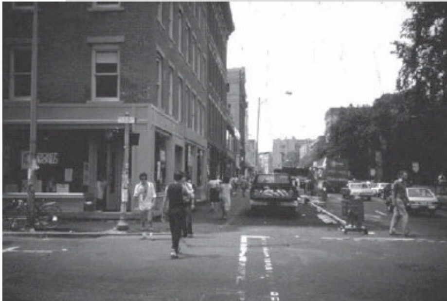
NEW HAVEN, CHANEL STREET PODCZAS PRZEBUDOWY
